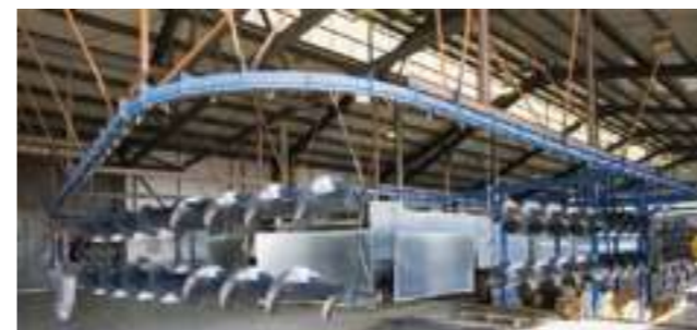
Instalación pintura en polvo
