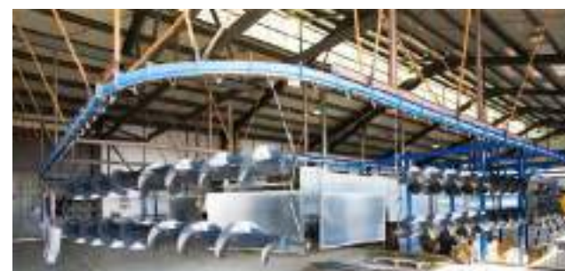
Instalación pintura en polvo
