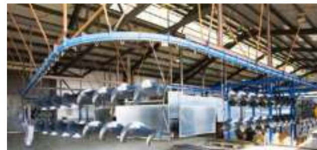
Instalación pintura en polvo
