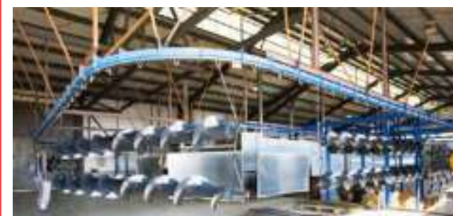
Installations de revêtement en poudre
