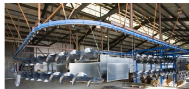
Instalación pintura en polvo
